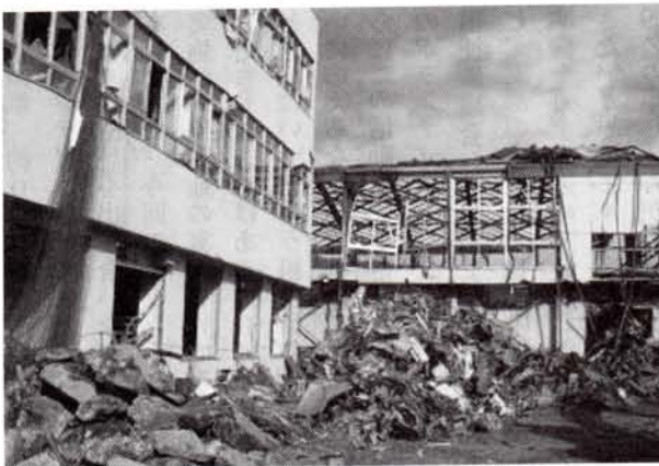
被災した気仙小学校
